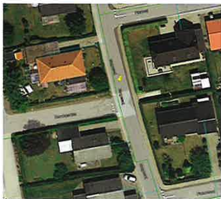
Dronen fandt ved hjælp af termofotografering dette ledningsbrud ud for Norgesvej 6
