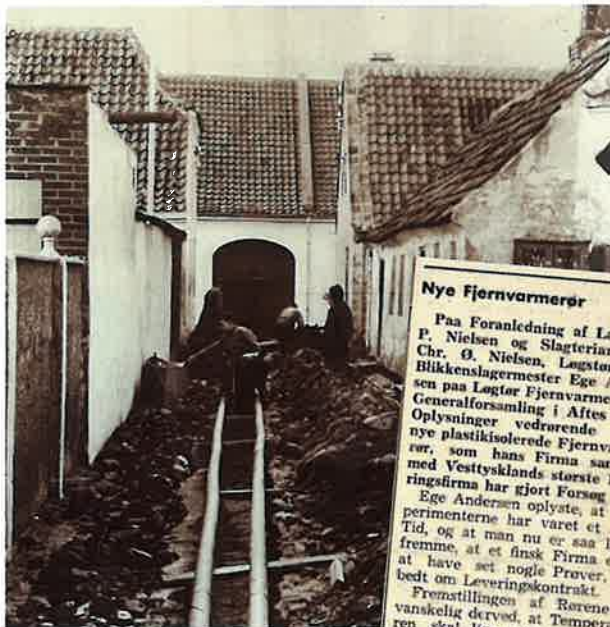
De første rør lægges ned i Strandstræde
