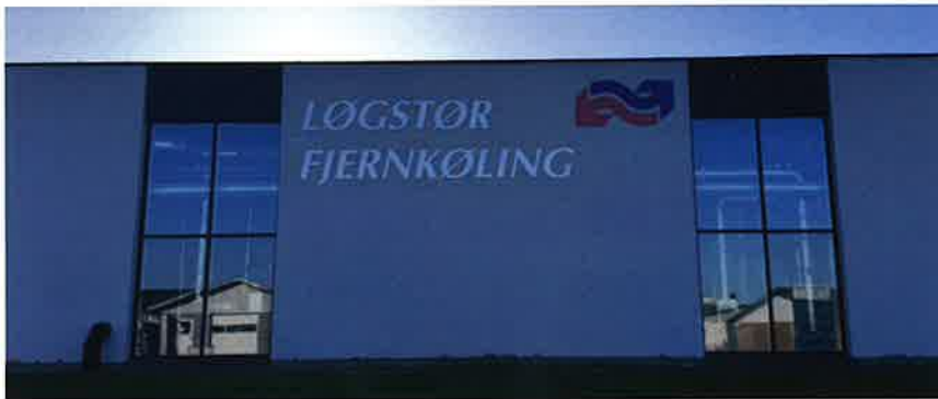
Løgstør Fjernkøling nedlægges snart, så bygningen vil blive brugt som "modtagestation" for overskudsvarmen fra Dankalk
