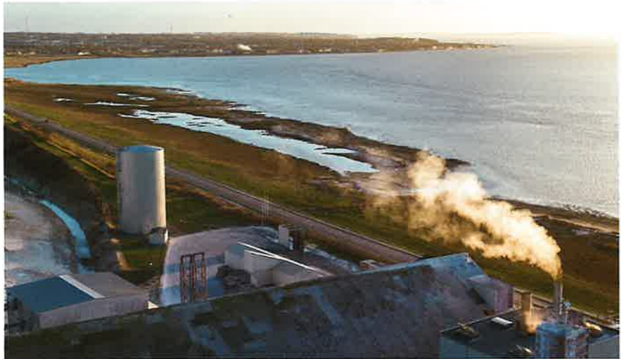
Den store akkumuleringstank ved Dankalk rummer 2800 kubikmeter- og det er egentlig den, der sætter grænsen for, hvor meget overskudsvarme, det er muligt at levere.
