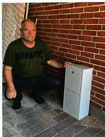
Det eneste synlige tegn på, at fjernvarmen er kommet ind i varmen er dette skab i garagen.
